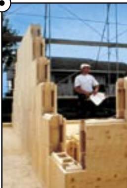
1 STEKO Holzmodul; 2 STEKO Schwelle 3 STEKO Einbinder; 4 Deckenelement
